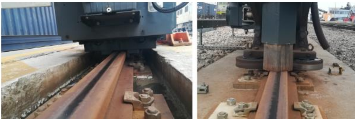
Rysunek 13 Szyna w korycie vs szyna bezpośrednio na belce
