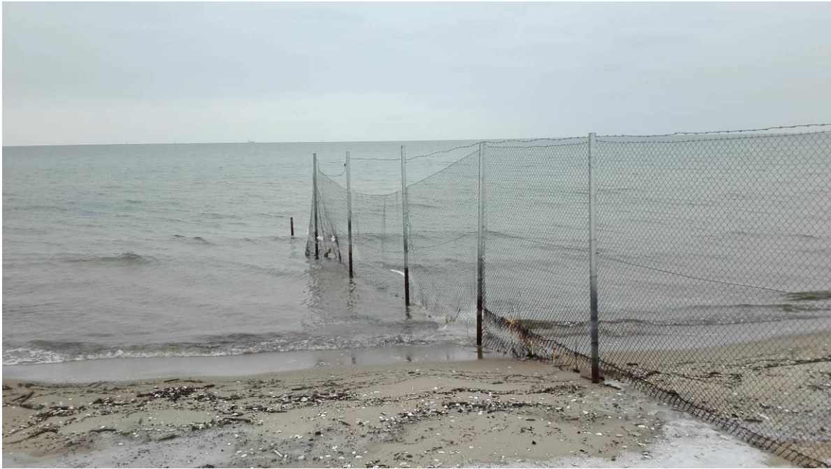
Cześć w wodzie. Wymaga naprawy, wydłużenia i umocnienia.
