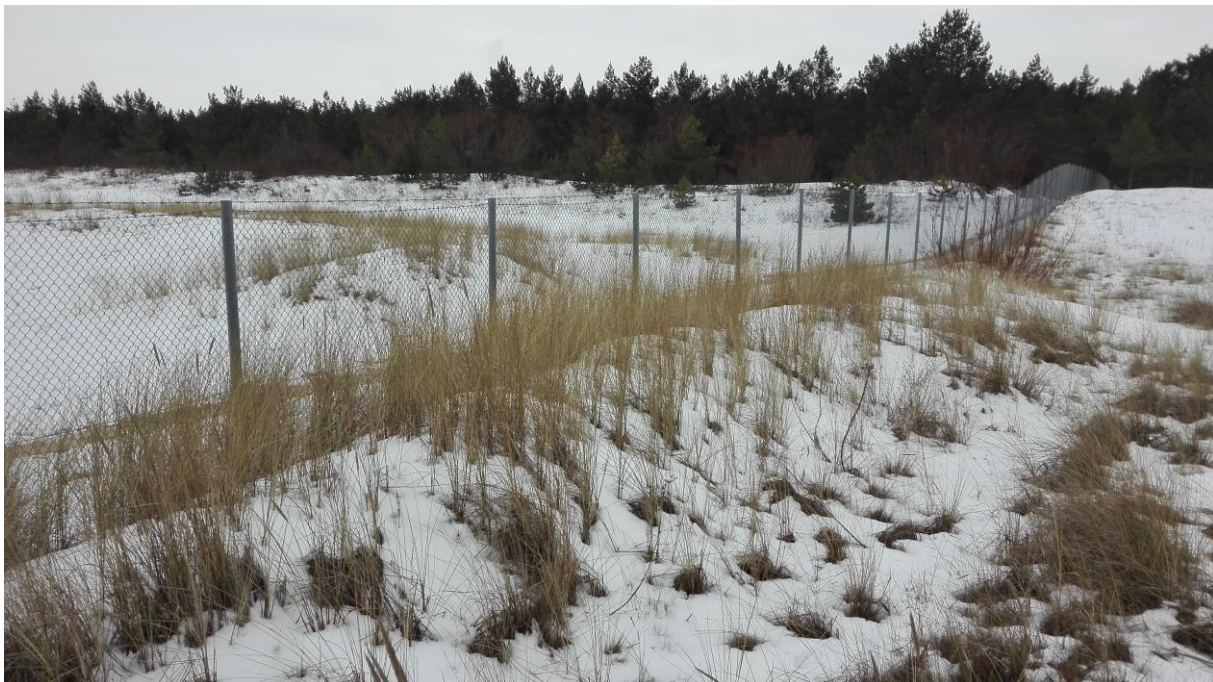
Nasyt utworzony na skutek ruchu piasku. Powinien być zlikwidowany, tak aby płot „odzyskał” docelową wysokość 2 m.
