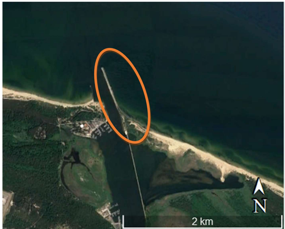
Rysunek 5.8 Ujście Martwej Wisły nie wykazało znaczącej akumulacji osadu na ścianie wschodniej
